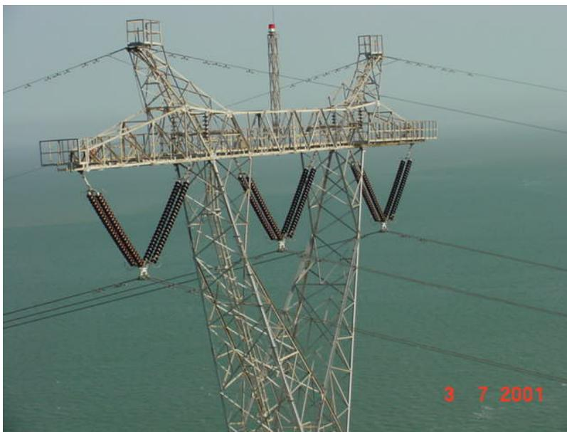
Figura 5.2. Cadena de aisladores de la línea de 400 kV sobre el Lago de Maracaibo, Venezuela.
